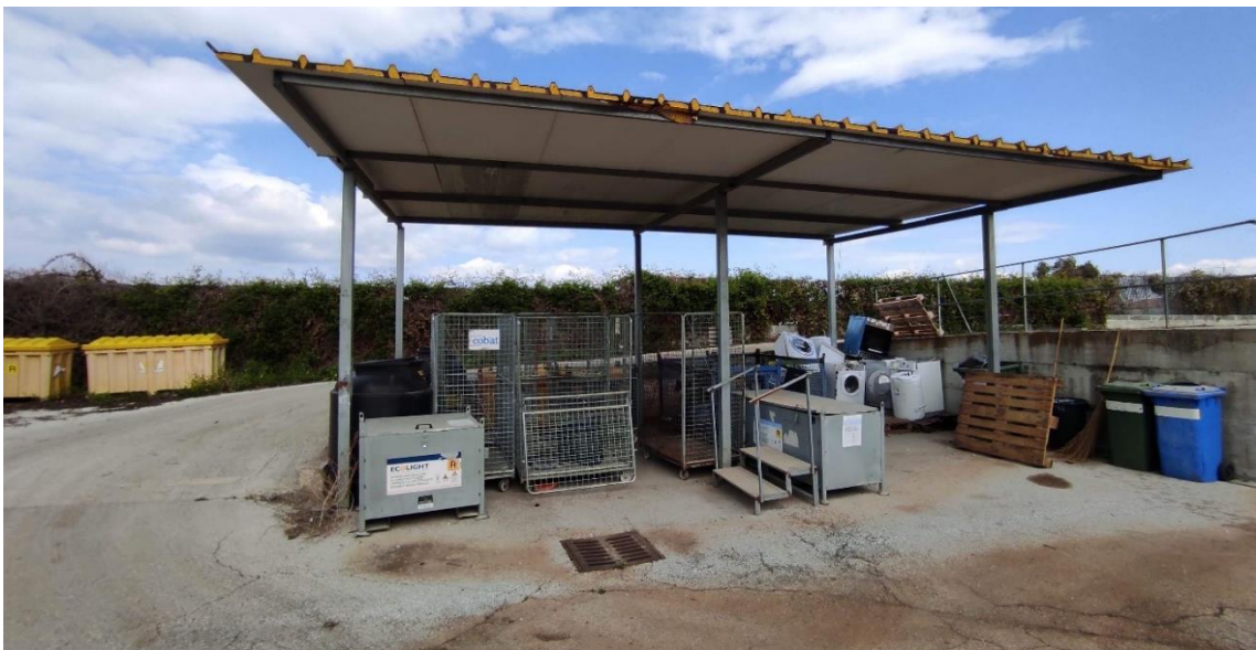
Figura 9 – Centro di raccolta. Tettoia esistente
